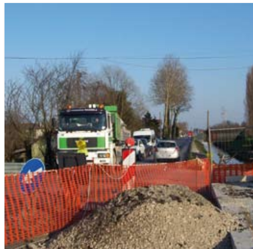
Rotonda fine lavori 1° lotto variante innesto su SP Mestrina loc. Pioppetto
